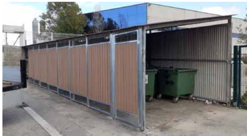
Detalls de la cobertura. Octubre 2020.
