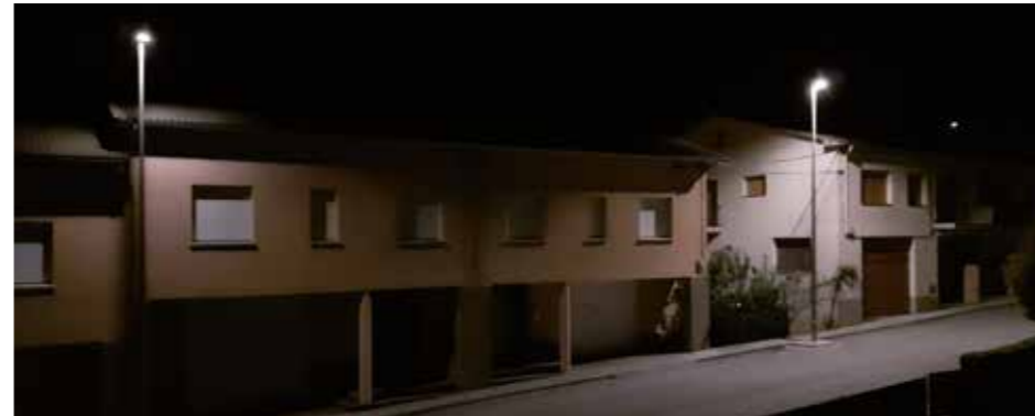
Nou enllumenat. Octubre 2020.
